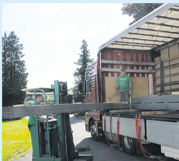
Dieses Foto zeigt die Anlieferung von Stahl für die Profilarmierung auf dem werkseigenen Gelände.
